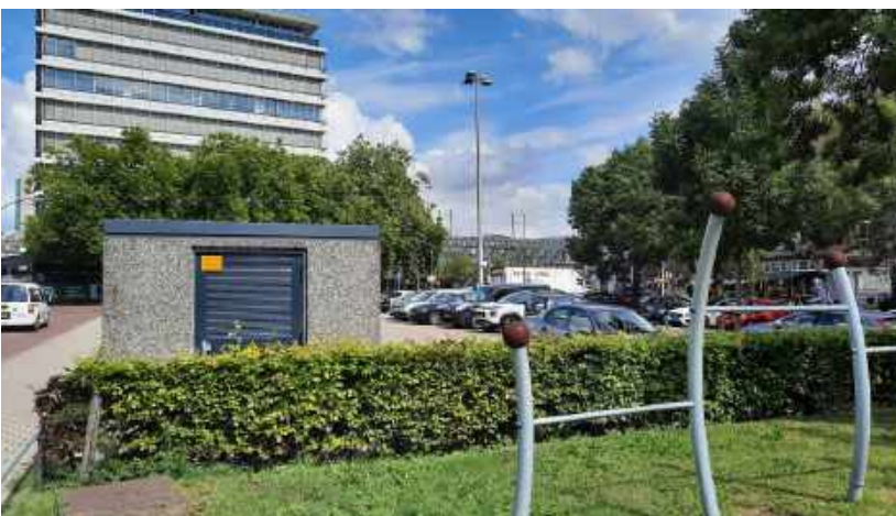
Afbeelding 3: Het noordelijk deel van het plangebied met daarop het transformatorhuisje, gezien vanuit het zuiden. Foto: M.M. Bouwmeester | Ecoresult B.V.
